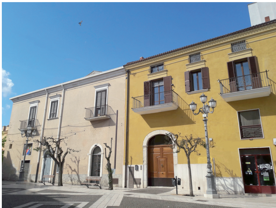
Torremaggiore, Palazzo ex convento dei Carmelitani sito in corso Italia.
